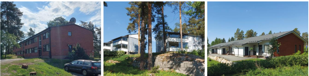
Kuvia suunnittelun alueen lähiympäristön rakennuskannasta. Alueen pohjois- ja itäpuolella sijaitsee eri ikäistä matalaa rivi- ja kerrostalorakentamista. (5/2024)
